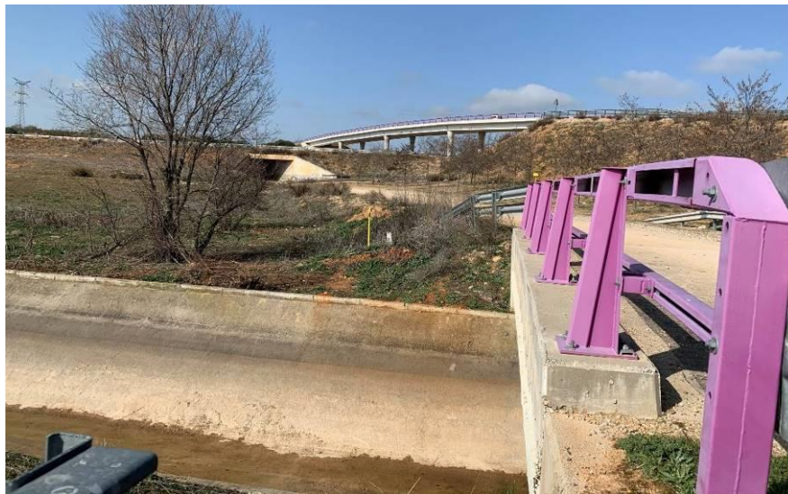
Imagen: cruce camino a Villanueva sobre Canal del Henares. Fuente CHIVA INGENIEROS, SL
