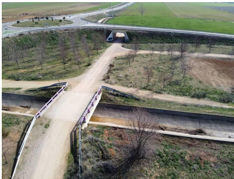
Imagen: cruce camino a Villanueva sobre Canal del Henares. Fuente CHIVA INGENIEROS, SL
